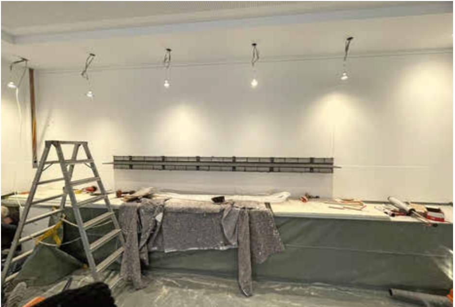
Der Raum Lukas verwandelte sich zunächst in eine große Baustelle. Hinten an der Wand ist bereits die Konsole zu erkennen, auf der die Skulpturengruppe nun platziert ist.
